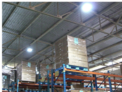
倉庫内の日中照明
